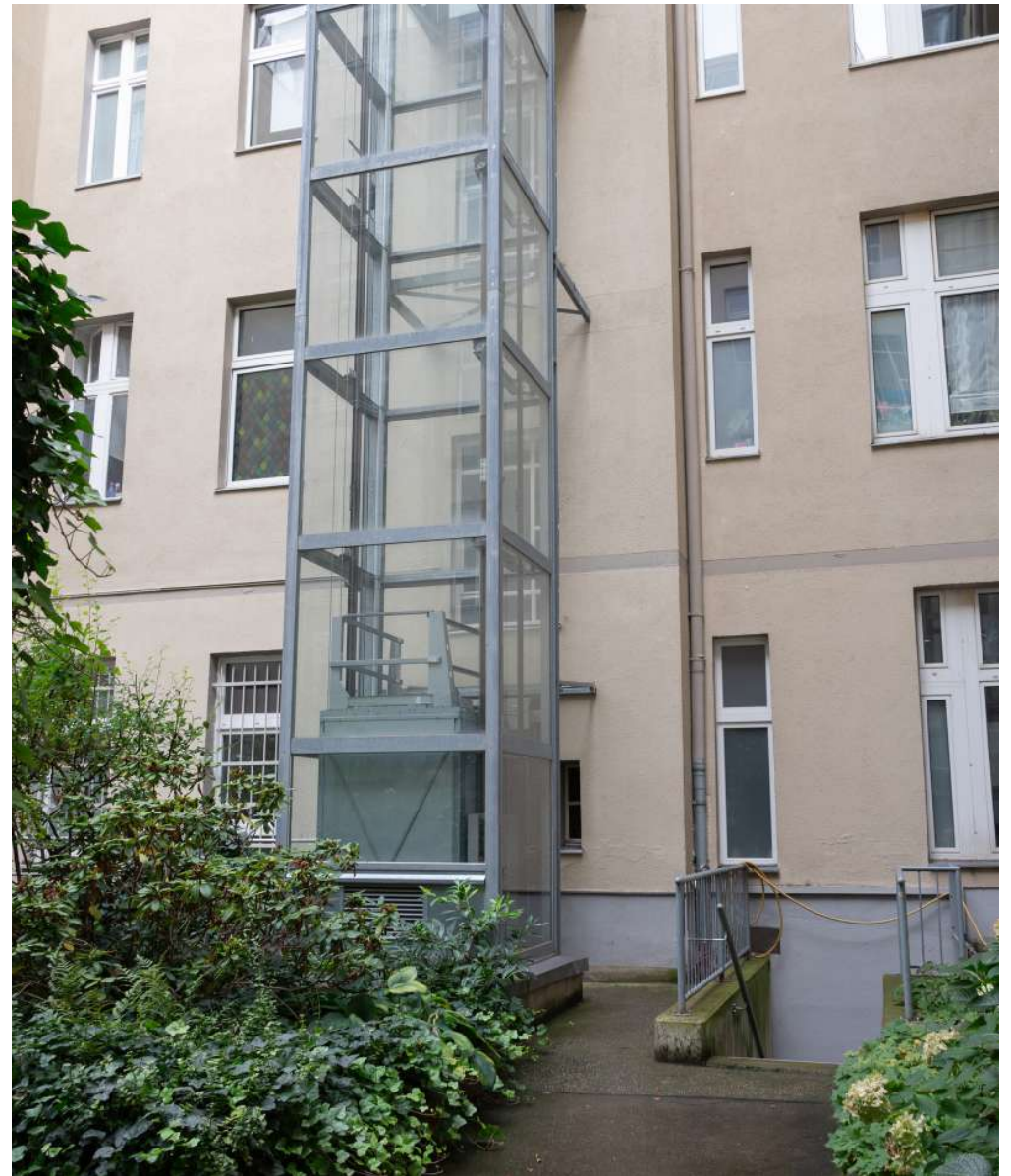
Aufzugseingang im Innenhof
